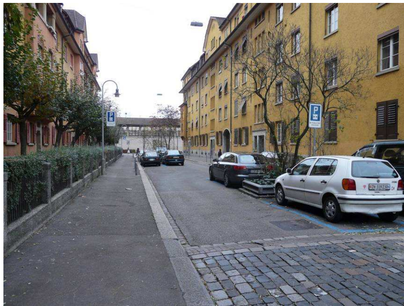
Exemples de dispositifs de resserrement de la chaussée dans une rue à sens unique avec stationnement
