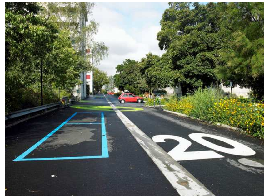
Modifier la perception de la chaussée par du marquage au sol (Genève)
